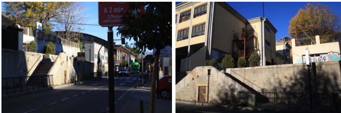
Fig 18 y 19. Una barandilla separa de forma drástica la calzada y la acera y, dificulta el uso peatonal del as Escaleras del siglo XVIII permiten salvar el desnivel con la Calle Juan de Toledo, que aparecen como elemento mal valorado en su dimensión patrimonial.
